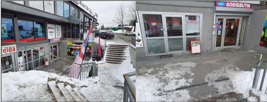
Figur 3-5. Lågpunkten intill byggnadens södra sida. Vänster bild visar trappan ned till källarplan och höger bild visar placering av rännan. Bilder tagna vid platsbesök 2021-02-17.
