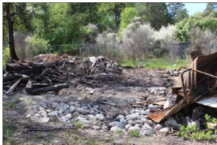
Resterna av rättarbostaden efter branden
