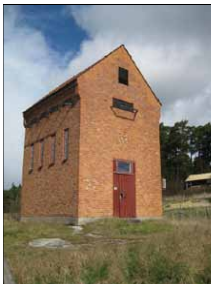
Transformatorstation vid Ormbacka
