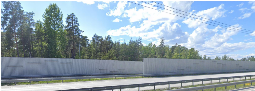
Figur 5-2. En skyddande bullerskärm löper längst E18 för den studerade sträckan. För påfarten löper också en skärm, vilket ger dubbelt skydd för delar av den planerade bebyggelsen. Bild hämtad från Google [10].
