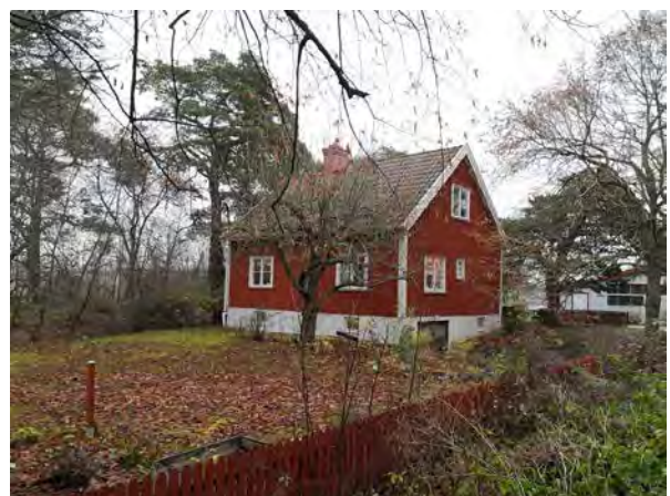
Bild 1 Röda stugan är den enda kulturhistoriska byggnaden (1930-talet) i området.
